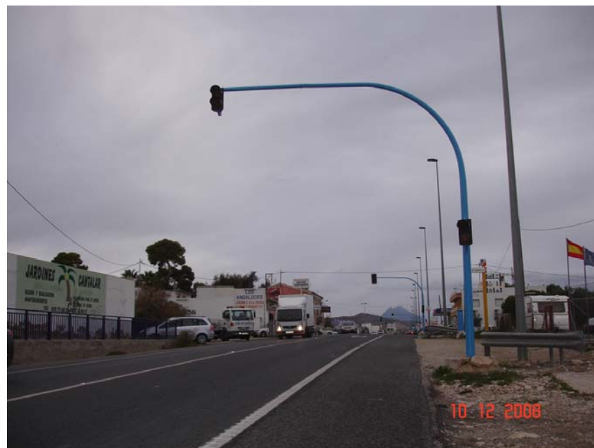
Ejemplo de tramo semaforizado.
